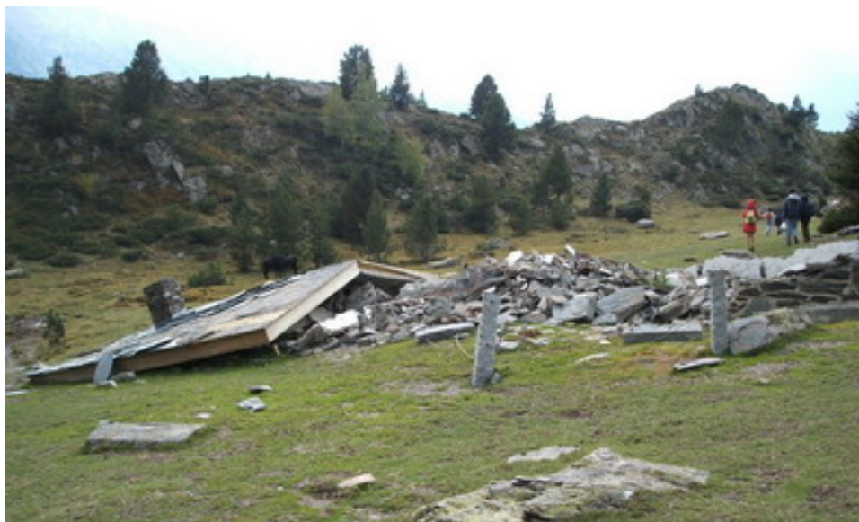
Fig. 6: Refugi de muntanya destruït per una allau de neu.
